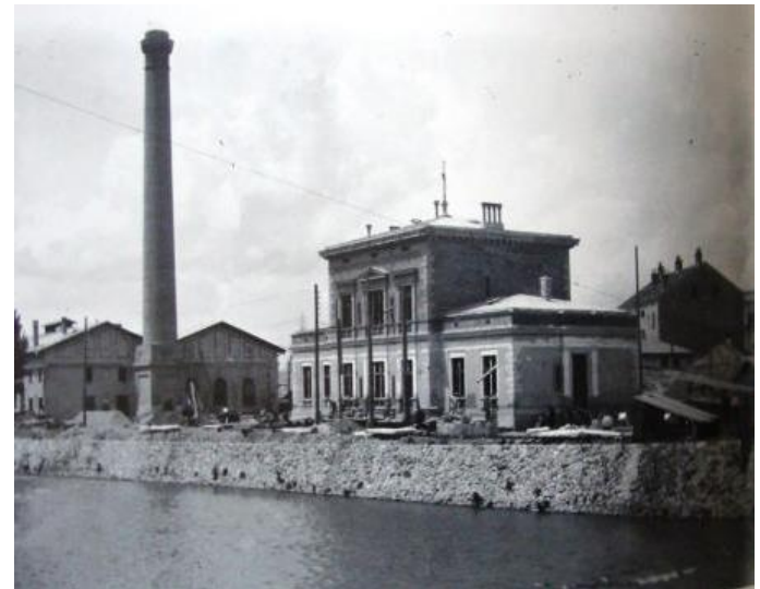
Fig 33:- Electrical Power Station, 19th Century (Source: Komisija za očuvanje nacionalnih spomenika BiH)
